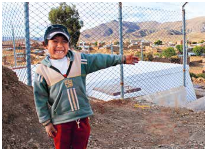
Milton zeigt begeistert das Wasserreservoir, das sein ganzes Dorf mit Trinkwasser versorgt.
